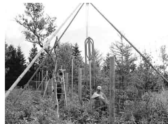
▲防鹿柵の鉄柱の付け替え作業
