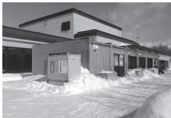
▲改修工事中の知床自然センター仮設店舗
